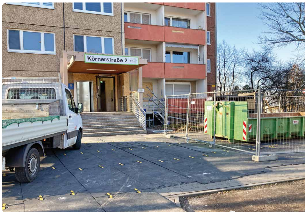
Umbau des Eingangsbereichs der Körner Straße 2
